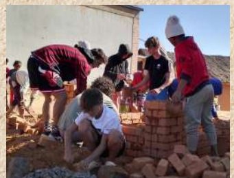
Eine konstruktive Zusammenarbeit auf der Baustelle in Madagaskar.
